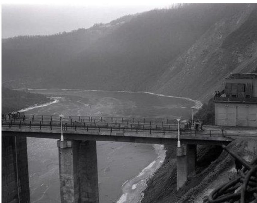
Na archívnej snímke z 21. decembra 1968 vodné dielo Ružín., Zdroj: TASR
